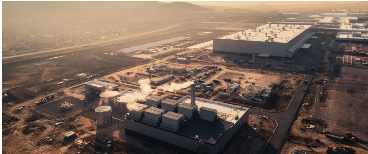
Energetické centrum JLR v Nitre
