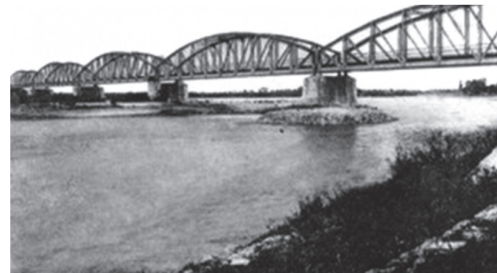
Bývalý železničný most cez Váh v Hlohovci.
