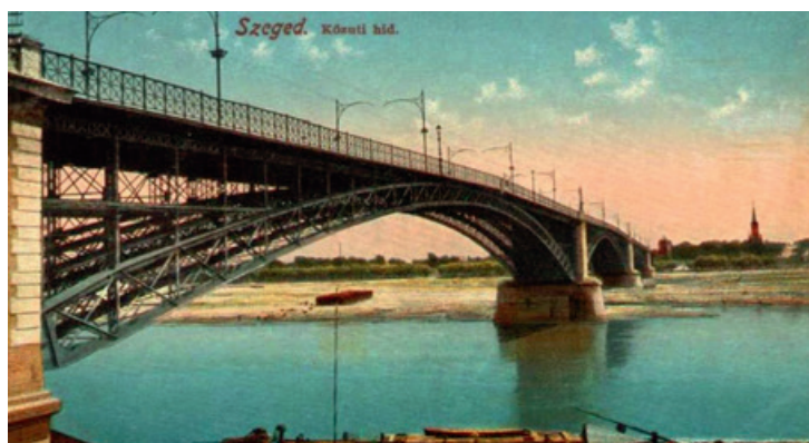
Bývalý cestný most v Segedíne, ktorý navrhol Feketeházy a bol postavený firmou G. Eiffela.
