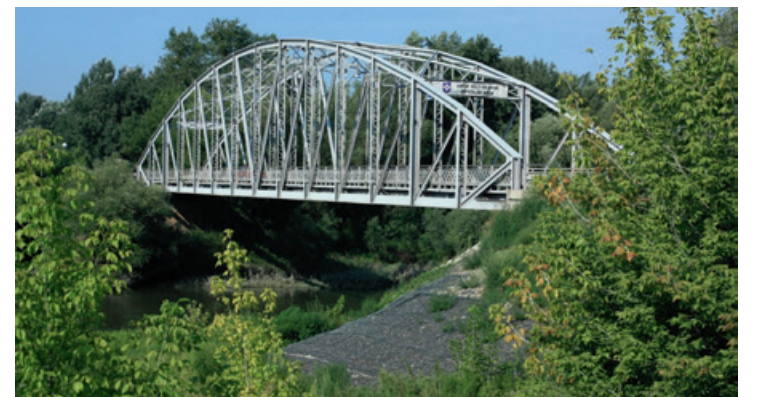
Kolárovo – cestný most (aj keď ho v roku 1945 zasiahla bomba, našťastie, nevybuchla, a tak most prežil až dodnes).
